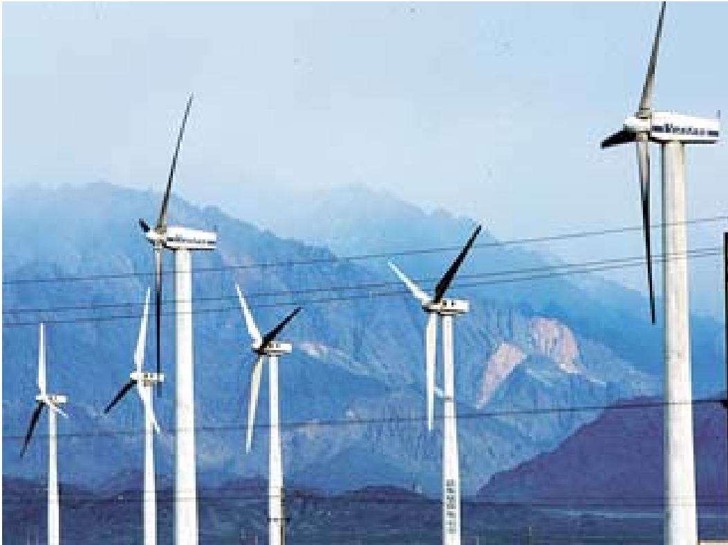
Aerogeneradores privados en Tehuantepec, Oaxaca
