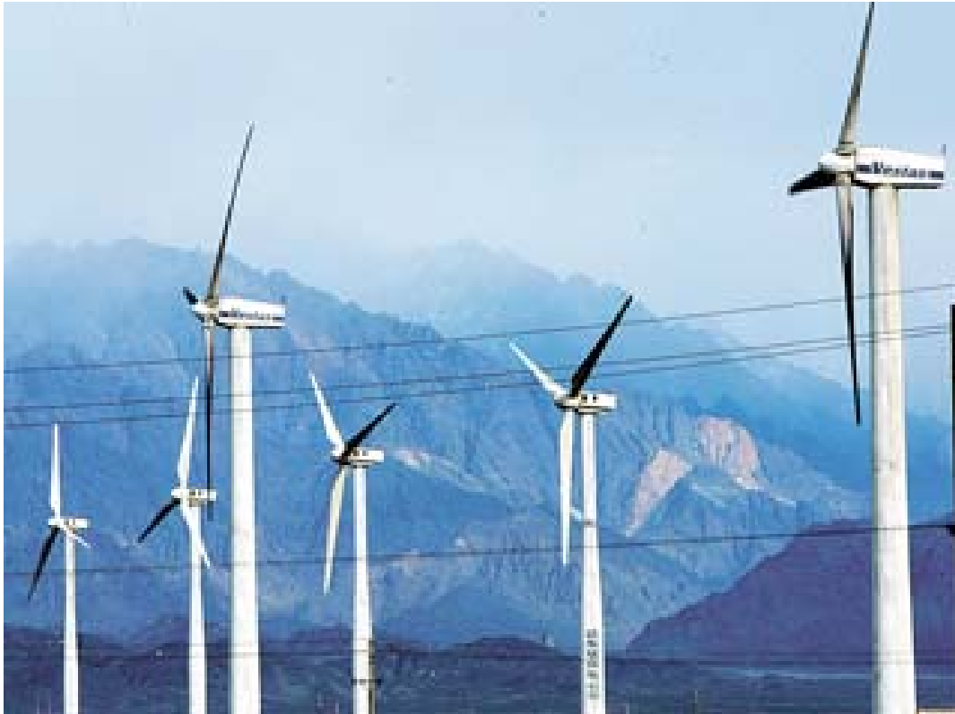
Aerogeneradores privados en Tehuantepec, Oaxaca
