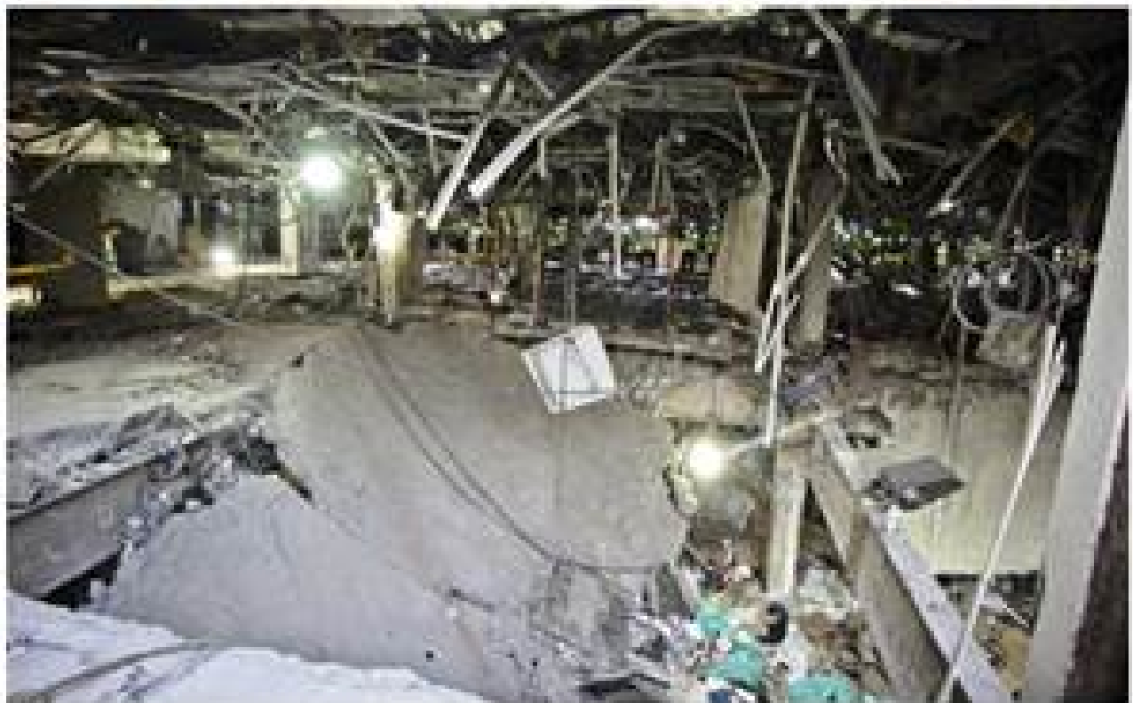
Escombros por la "explosión" en el edificio B2 de la torre de Pemex. Financial Times recomienda a Peña Nieto aprovechar la tragedia para imponer la contra-reforma energética.
