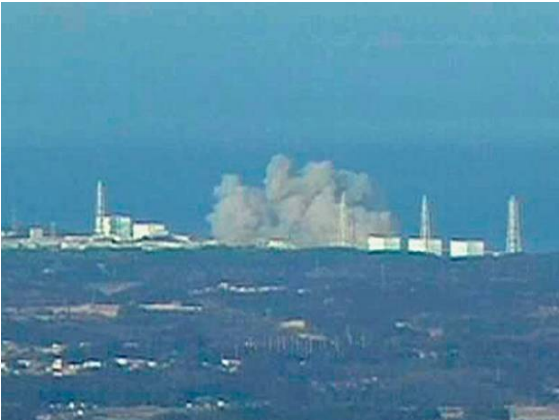
Explosión de hidrógeno en los reactores de la central nuclear de Fukushima
