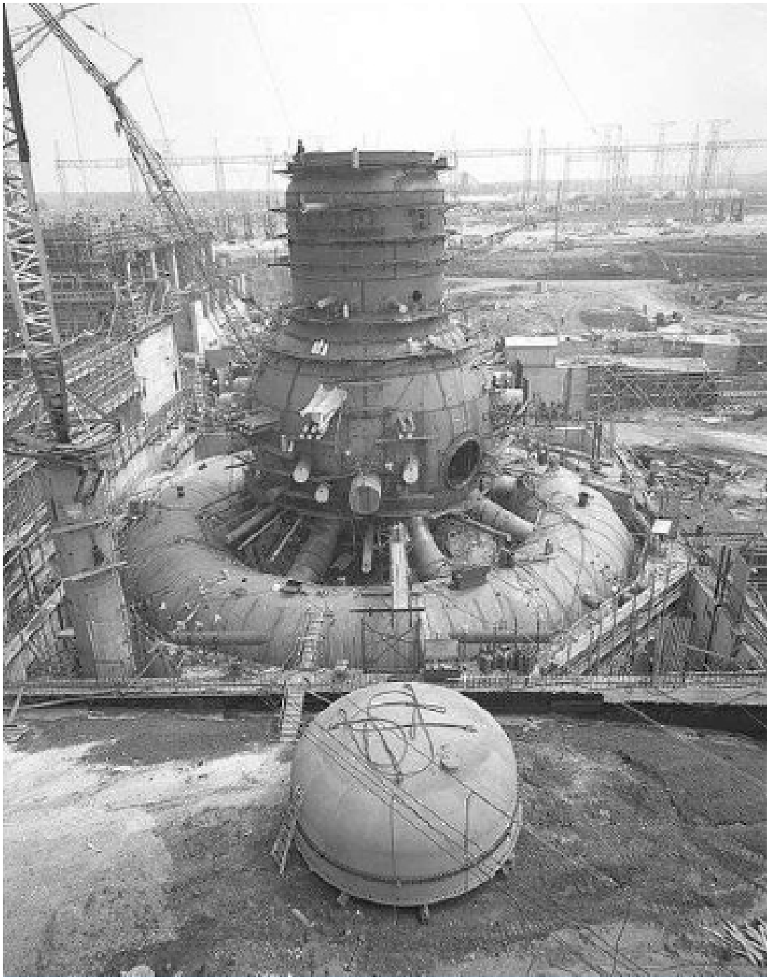
Edificio en construcción del reactor BWR japonés FOTO: TVA/OIEA
