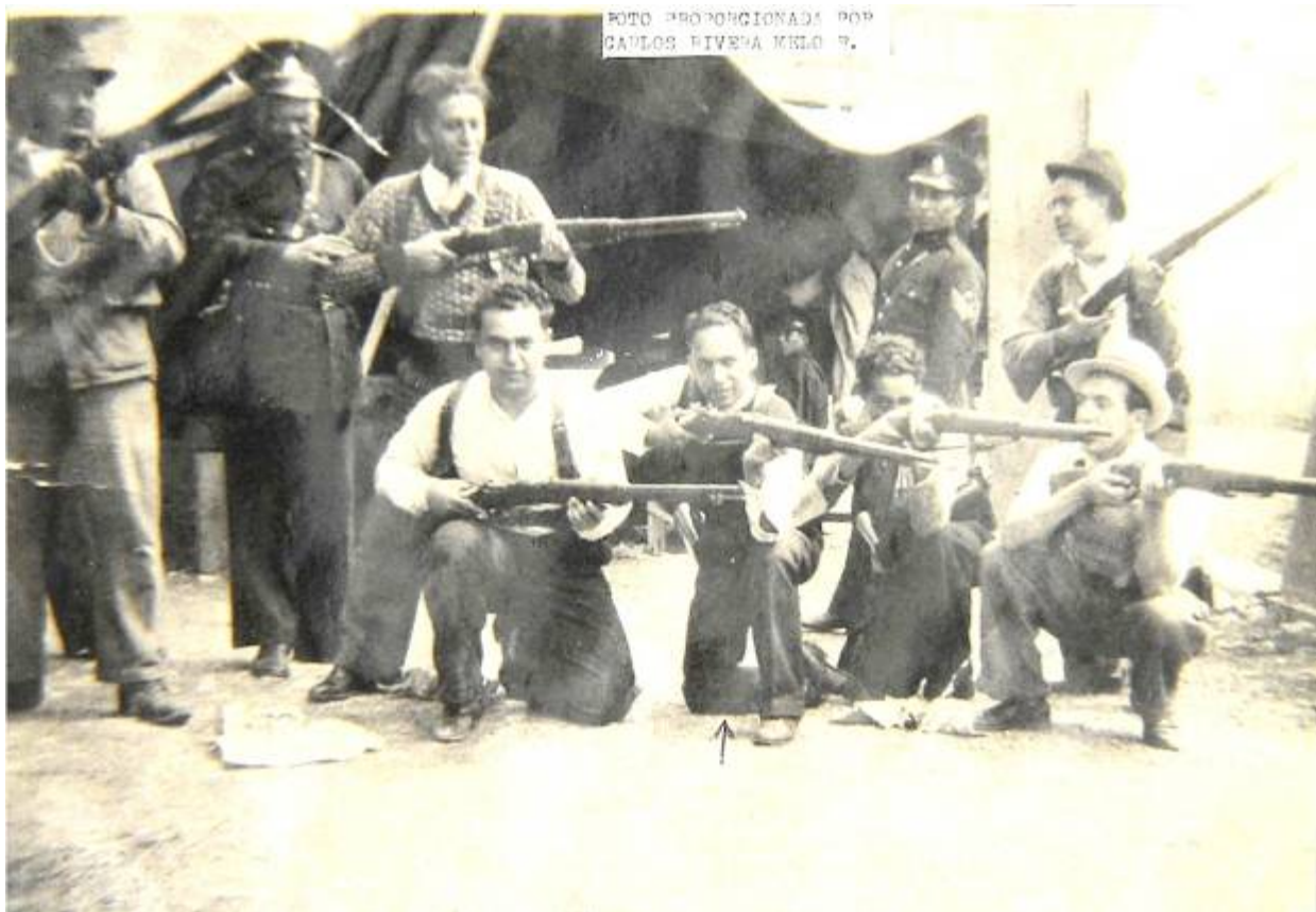
Piquete de huelga en la Subestación Taxqueña. Huelga eléctrica del SME, 1936
