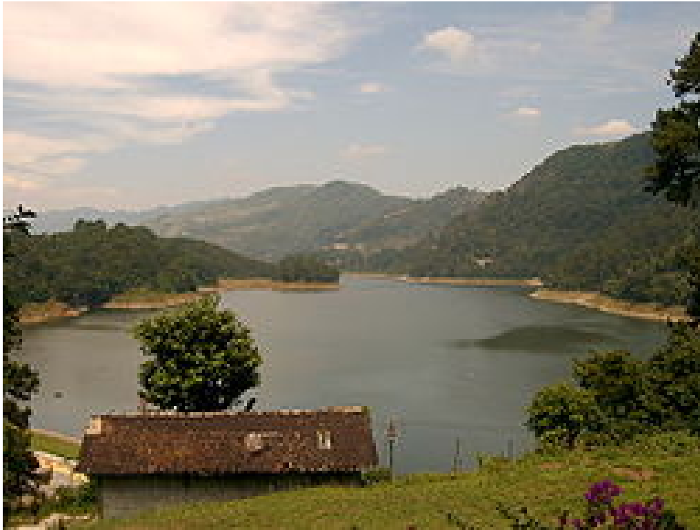
Presa de Necaxa para la operación de la central hidroeléctrica
