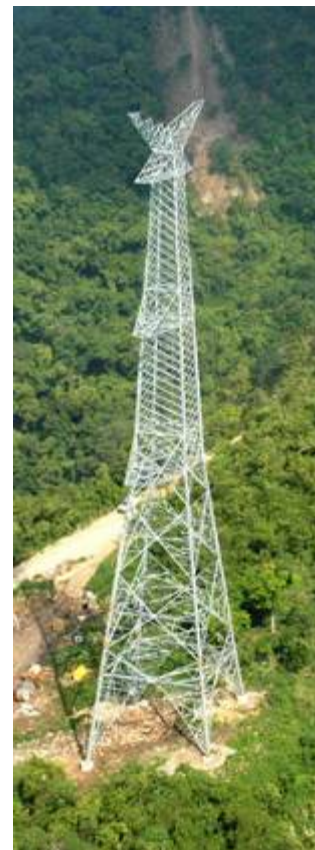
Transmisión del Sistema Eléctrico Nacional
