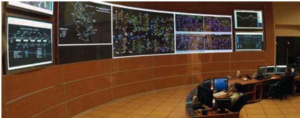
Centro Nacional de Control de Energía
