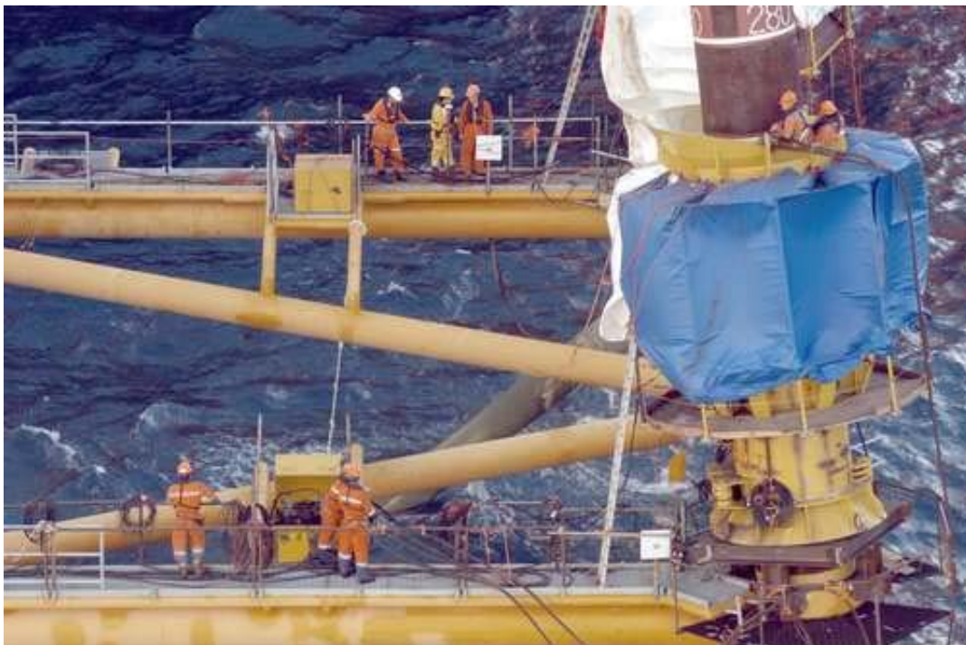
Trabajos en el complejo petrolero Cantarell
