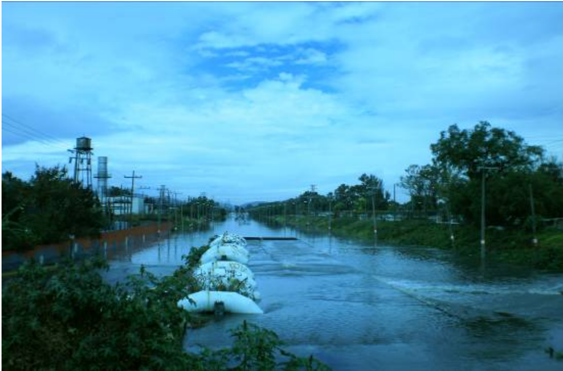
El canal de aguas negras que desemboca en el río de los Remedios desbordado el día 4 de febrero de 2010. FOTO: MEGA.
