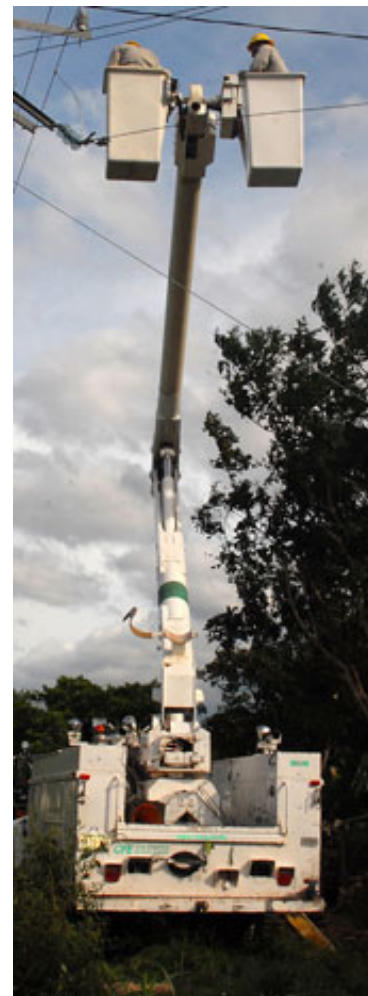
Trabajo en líneas aéreas
