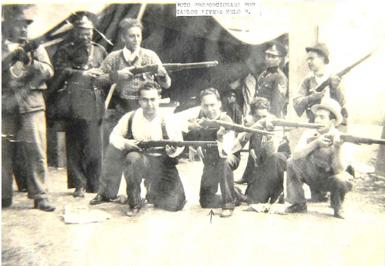
Piquete de huelguistas electricistas en la subestación Taxqueña, 1936
