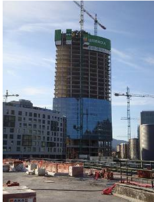
Torre Iberdrola en Bilbao
