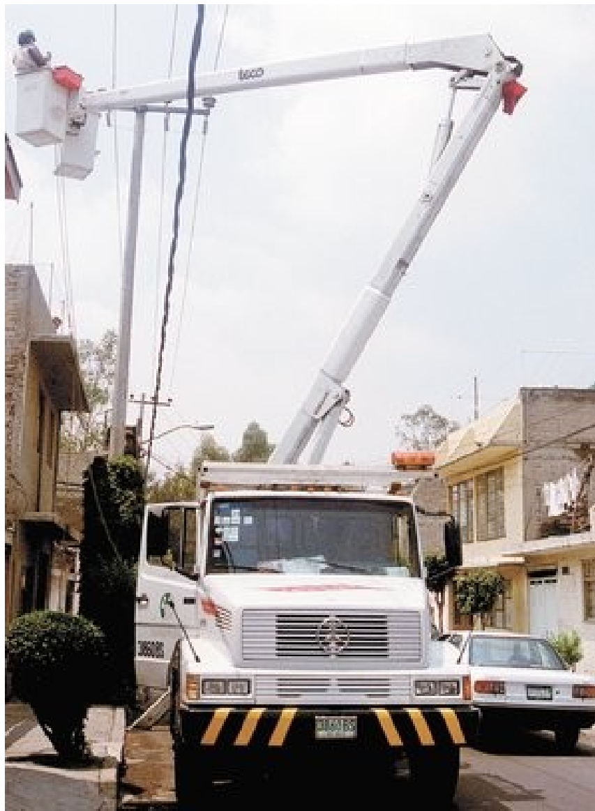
El proceso de trabajo eléctrico no se ha extinguido, la materia de trabajo en la región central del país subsiste
