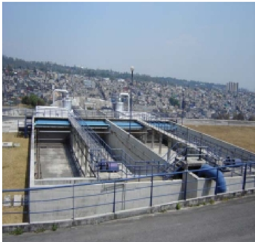
Planta Coyoacán de tratamiento de aguas residuales
