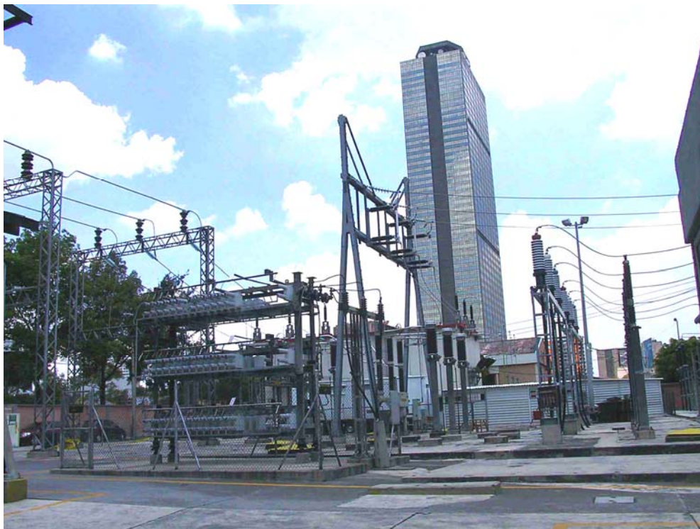
Subestación eléctrica y al fondo la Torre de Pemex
