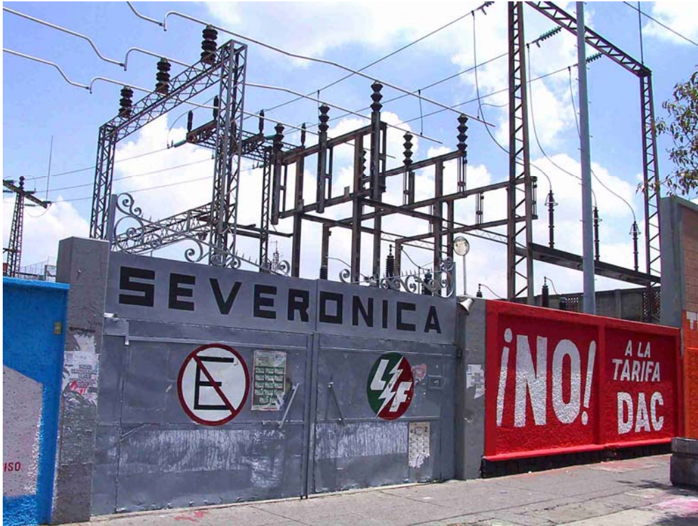
Subestación eléctrica Verónica, LFC
