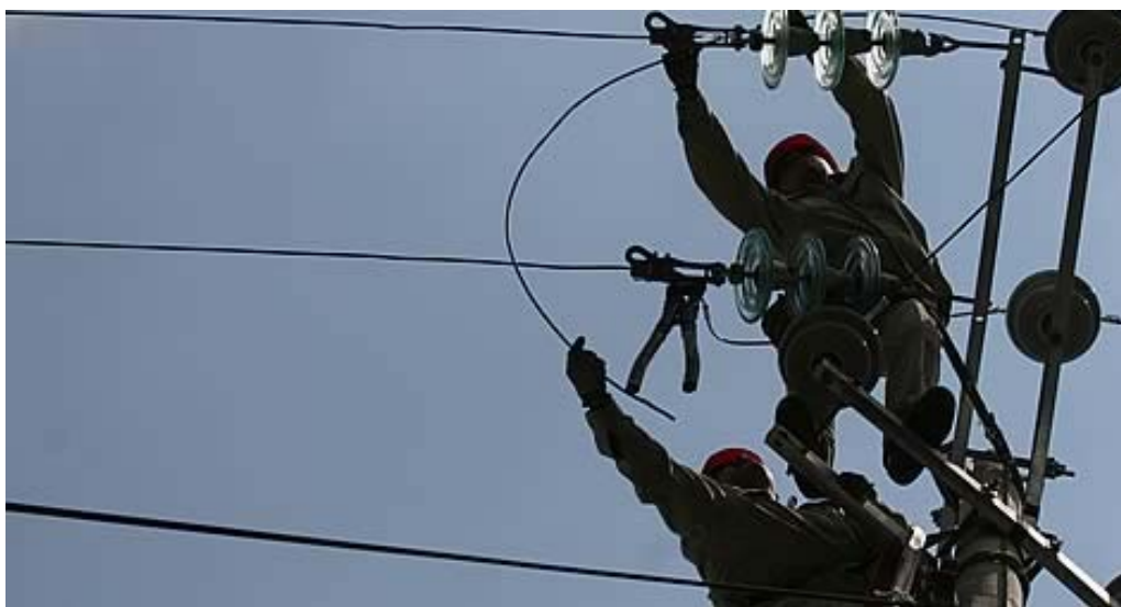
La CFE construye redes para regalarlas a las trasnacionales
