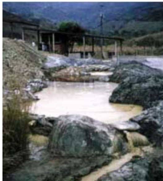
Presa de jales mineros
