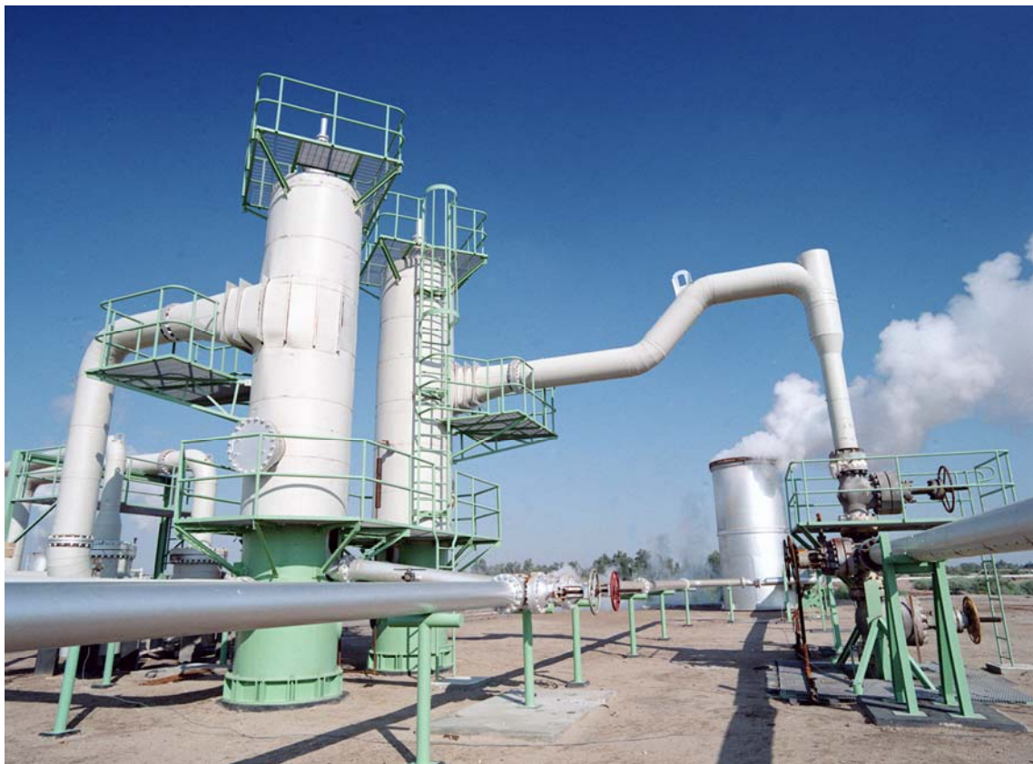
Campo geotérmico de Cerro Prieto, en Baja California
