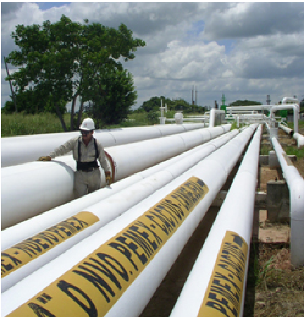
Ductos de Pemex en Cárdenas, Tabasco
