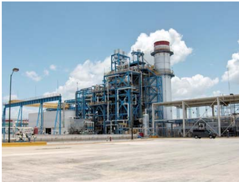
Central eléctrica Campeche I
